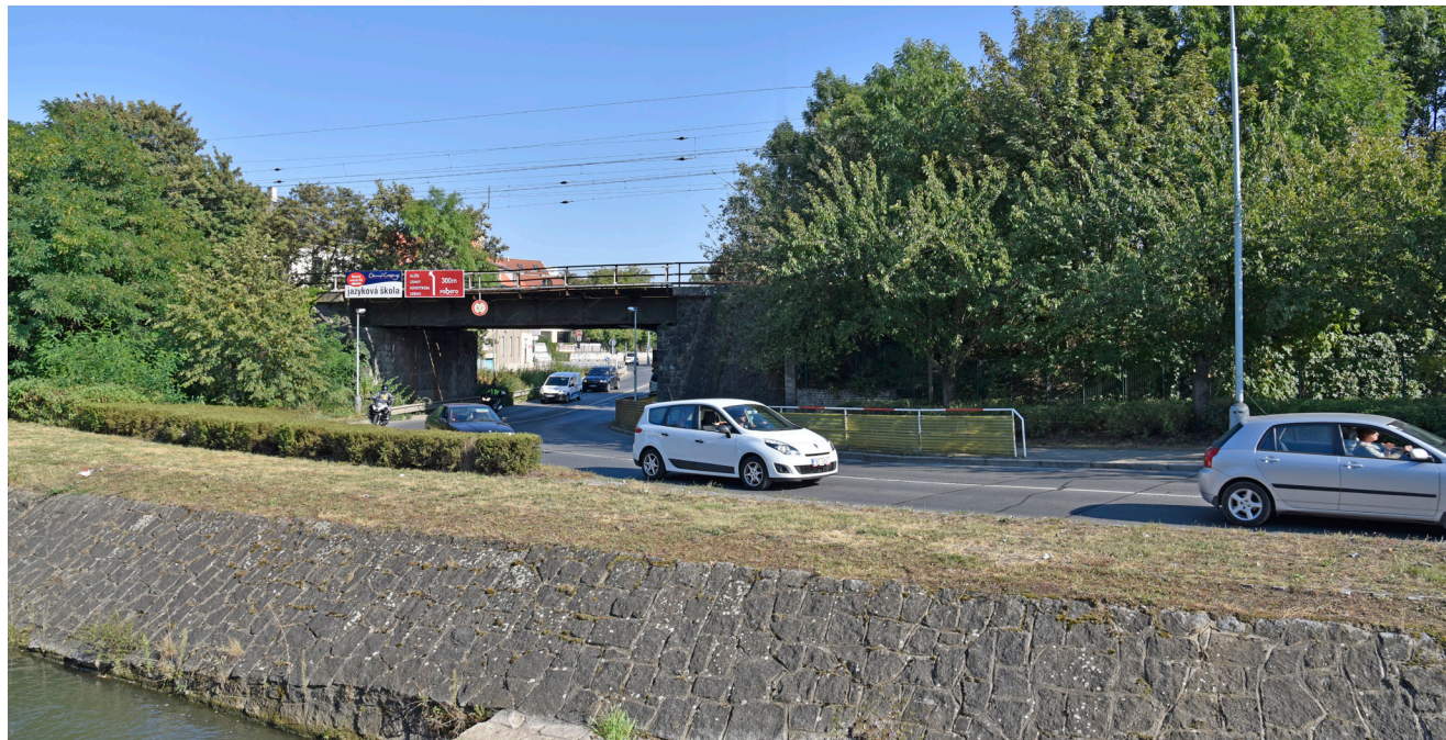
01 — Řada staveb na této trati je již nyní na hranici své životnosti
